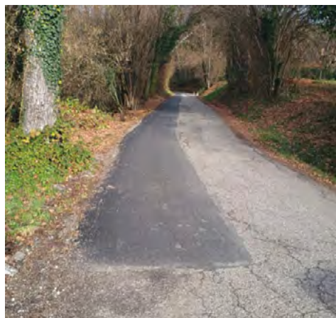
Route des Nantets : reprise des accotements afin d'améliorer la stabilité et la sécurité des usagers.
