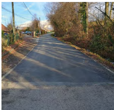
Route des Nants : goudronnage en pleine largeur accompagné d'une reprise complète de la chaussée, compte tenu de son état général.
