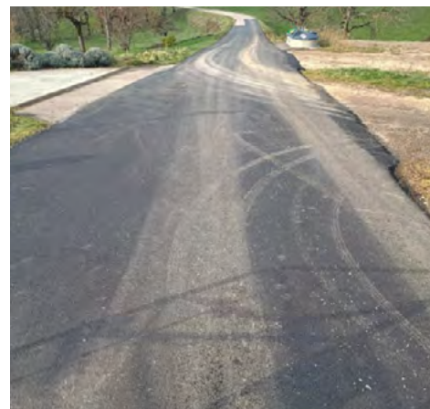
Chemin des Suavets : goudronnage en pleine largeur pour améliorer le confort de circulation.
