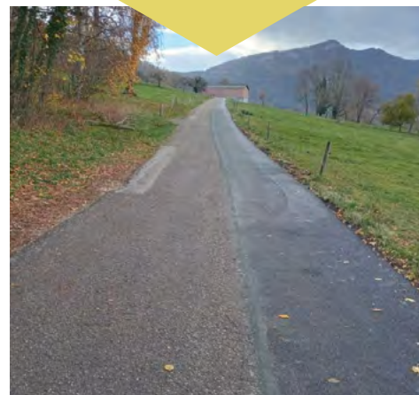
Route des Huguets : goudronnage et formation de cunette Chemin des Cermilliers : goudronnage des accotements
