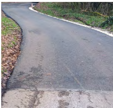
Route des Farniers : traitement des accotements Route du Rocheret : goudronnage pleine largeur
