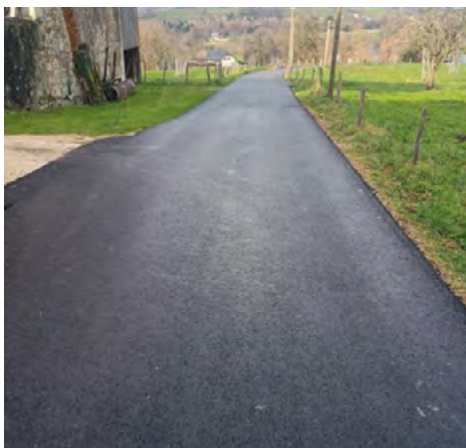
Route du Longeret : goudronnage en pleine largeur pour offrir une chaussée homogène et durable.
