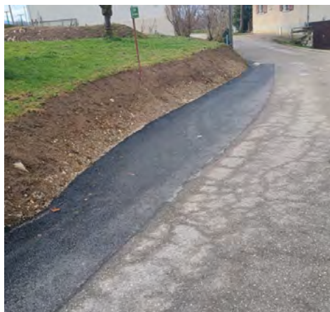
Route de la Pareuse : reprise de tranchée Croisement du Longeret : élargissement de la route.
